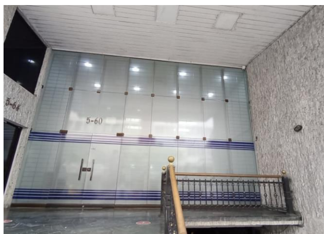
Fotografía 54. Fachada de la Sede Operativa de Catastro
