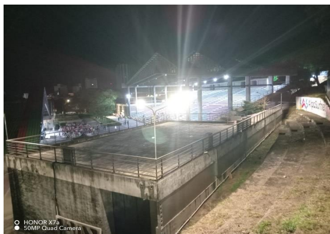
Fotografía 23. Instalación de luminarias de la Alcaldía en el parque de la música
